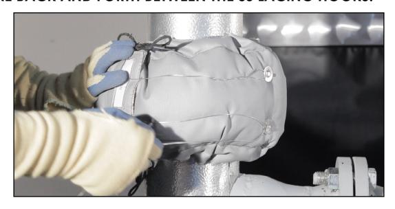
5. TRIM OFF ANY REMAINING SS WIRE USING THE WIRE-CUTTING PLIERS, ONCE YOU HAVE FINISHED LACING IT AROUND THE ISOCOVERS INSULATION JACKET.
